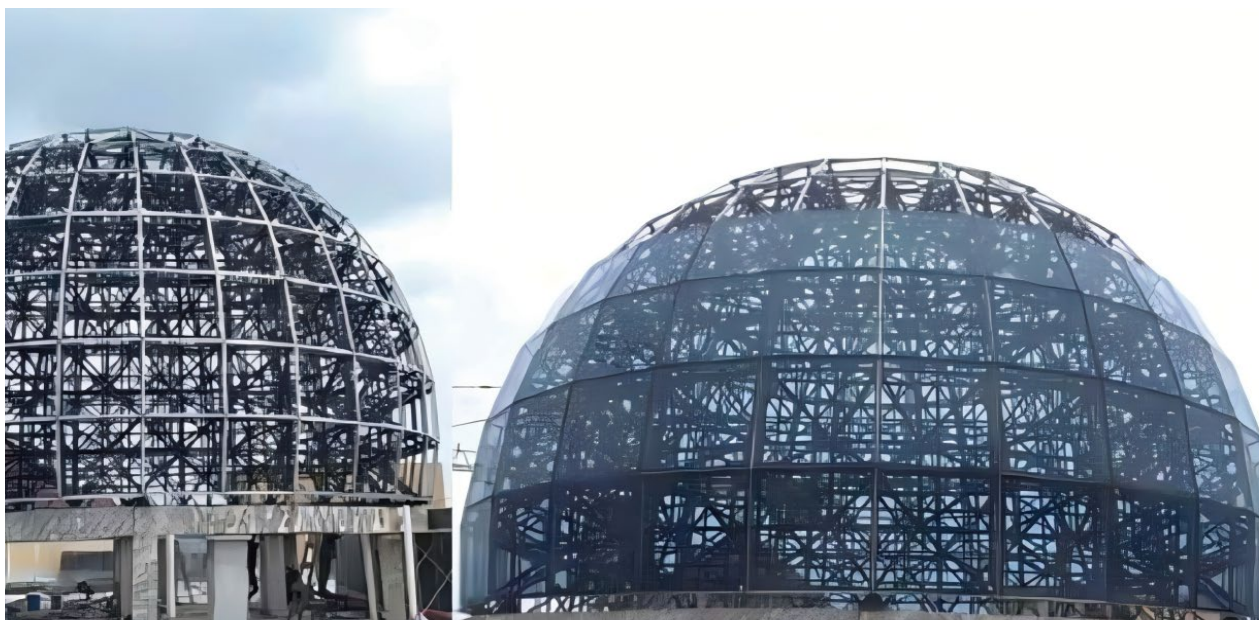
冷水江市公务员住宅小区综合楼穹顶网架工程
