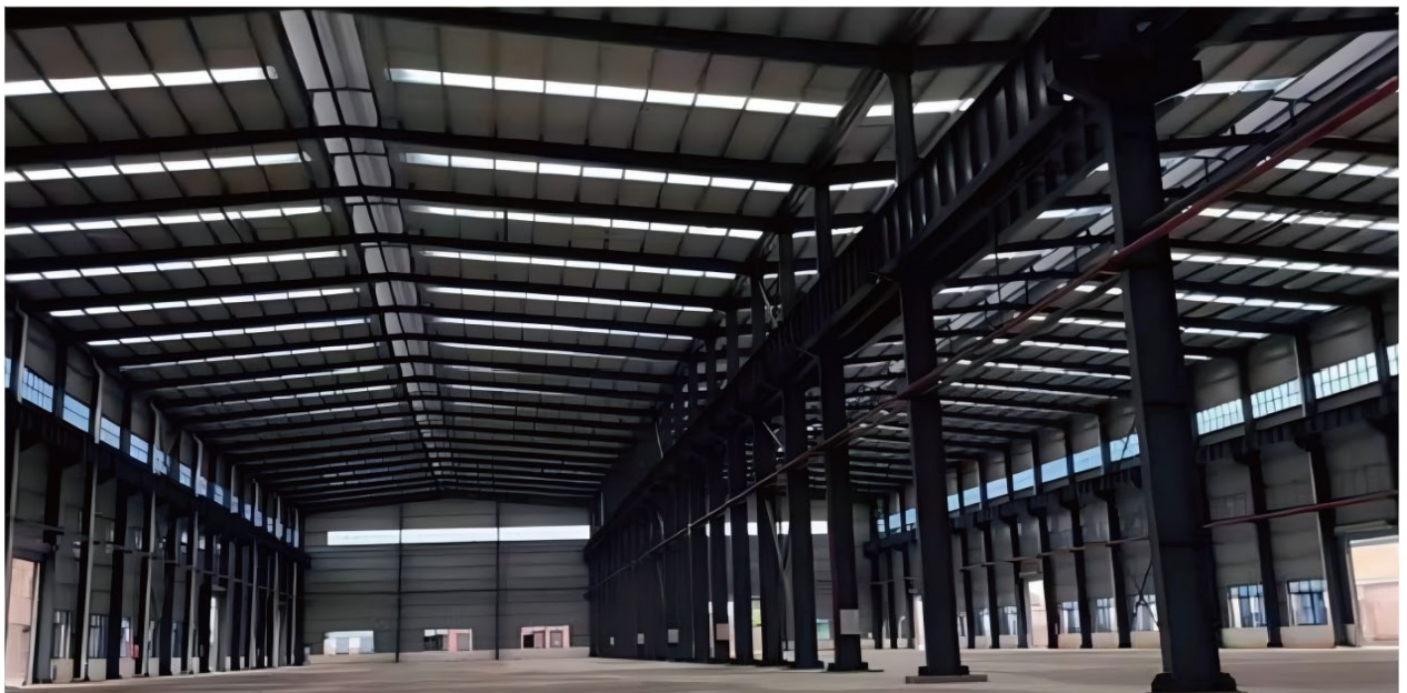
中国铁建重工轨道钢结构生产车间
