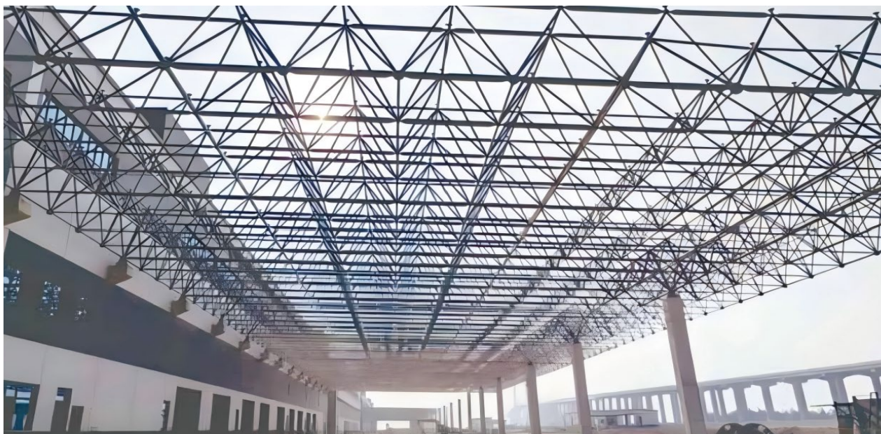
珠海格力电器总部搬迁装卸台网架项目
