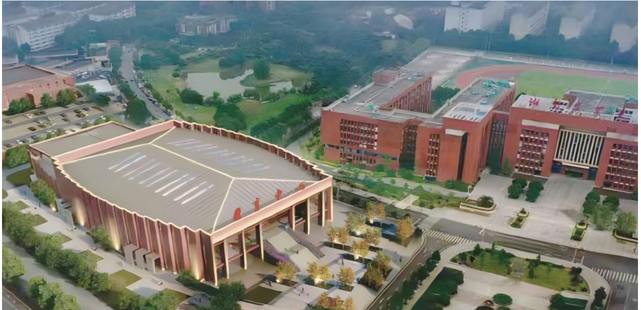
湖南农业大学新建体育馆网架项目
