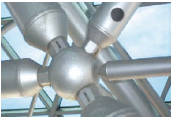
网架节点 Space Frame Joint
