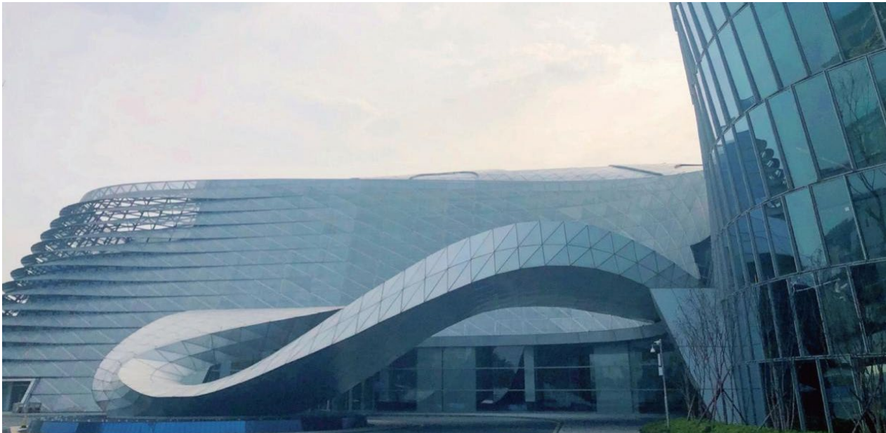
大王山冰雪世界钢结构工程
