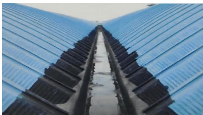
屋面防水处理 Roof Waterproofing Treatment
